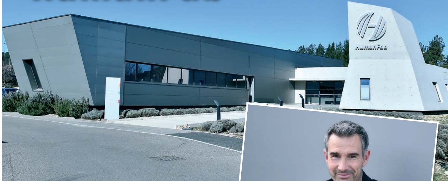
Un complexe à la pointe de la technologie dans le quartier du Val de l'Arc largement dédié au sport.
